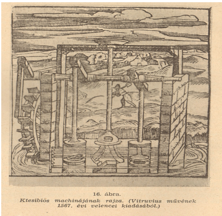
Kteszibiosz vízemelőjének rekonstrukciós rajza
